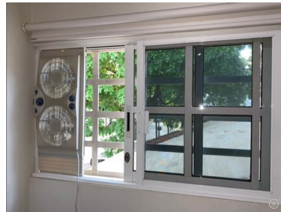
Las paredes flexibles se colocan dentro de los rieles por donde corre la ventana.
